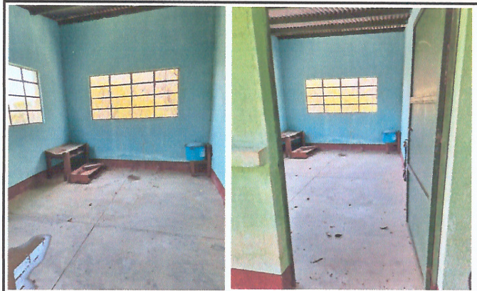
Foto 2: Área donde se instalara la cocina rural y la pila, no se cuenta con cocina en el establecimiento.
